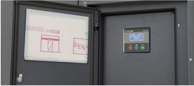
**Variant +11 (QLE-A-V-SC (50-250 LT))****Многофункциональный панель без встроенного переключателя**
